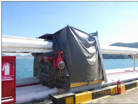
รูปที่ 2-23 ติดตั้งผ้าใบกันไฟขณะปฏิบัติงานเชื่อม
