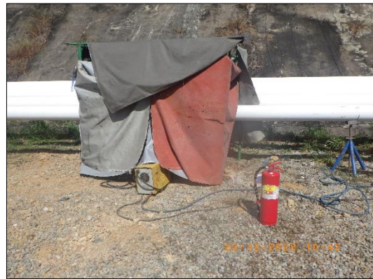
รูปที่ 2-23 ติดตั้งผ้าใบกันไฟขณะปฏิบัติงานเชื่อม
