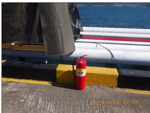
รูปที่ 2-17 ถังดับเพลิงแบบมือถือ
